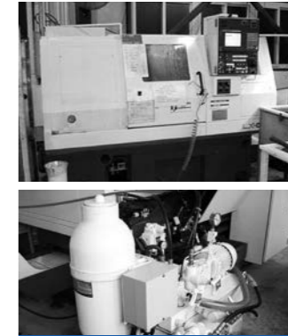
アキュムレータ付油圧ユニット NC旋盤の油圧ポンプ電動機の消費電力量削減
